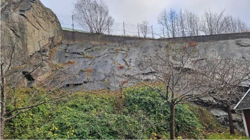
Figur 4. Bild från bergslänt med betongstödmur längs släntrön väster om Brasilia.
