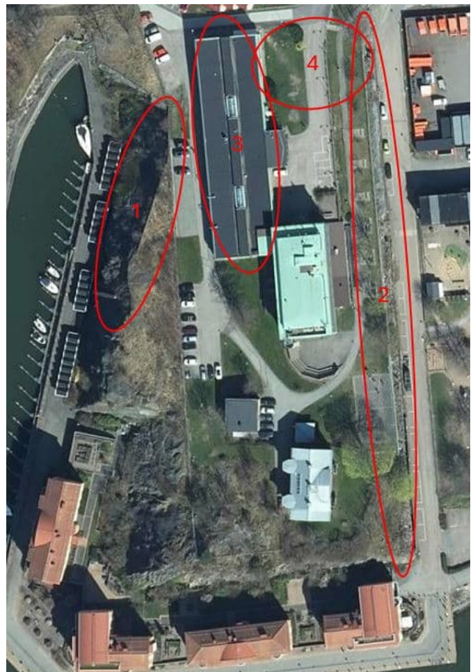
Figur 3. De fyra delområden som inspekterats avseende berg- och betongkonstruktioner, delområdena har markerats med röda ellipser.
