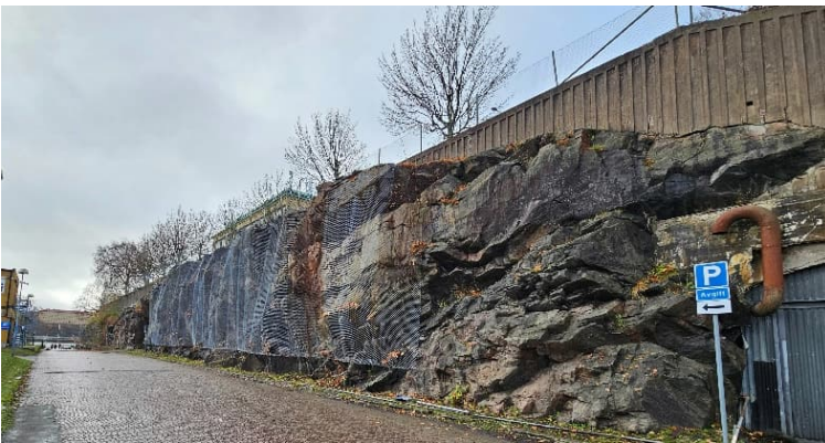
Figur 5. Bild på bergslänt samt stödmur i delområde två.
